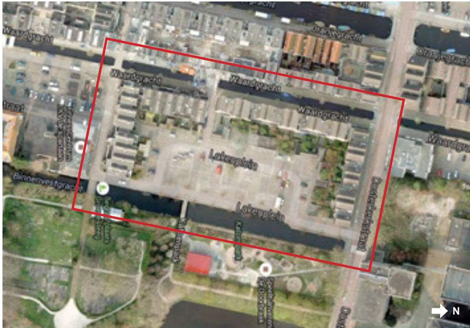
Voormalige situatie voor de sloop van de woningen.
